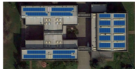
68 kWp - Liceo Pandini di Sant'Angelo Lodigiano In corso di realizzazione
