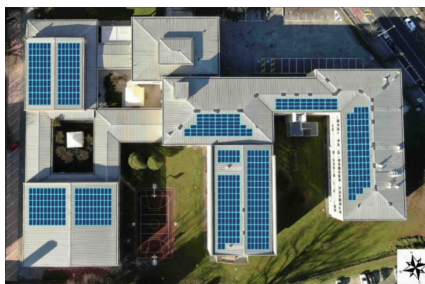
312 kWp Liceo scientifico Gandini e Istituto Volta In fase di allaccio
